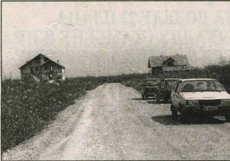
Општина се брине о инфраструктури: урађен је прилазни пут, а ради се и главна улица у насељу
