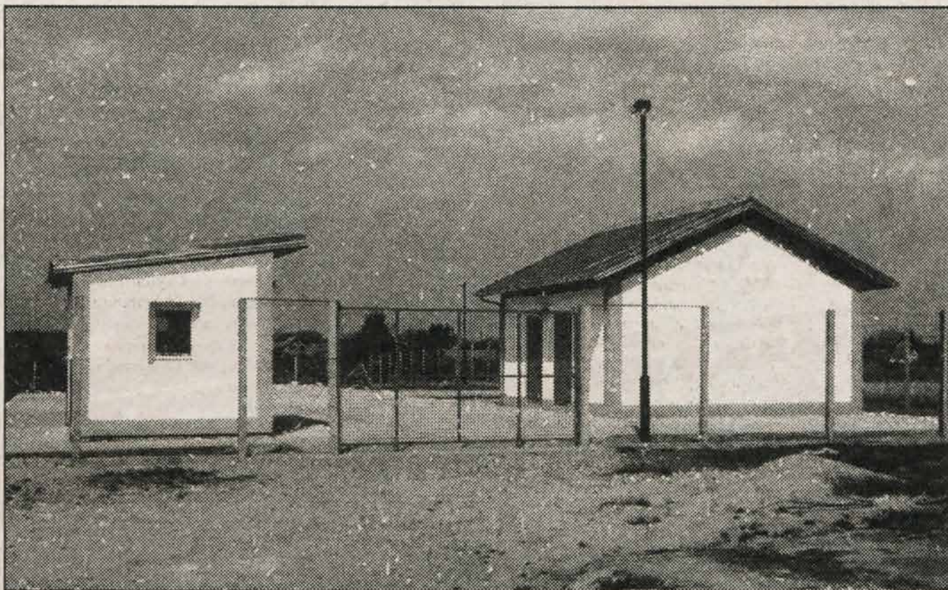
Станица за дохлорисавање воде у насељу Јаково била је приоритет општини Земун у циљу обезбеђења исправне пијаће воде
