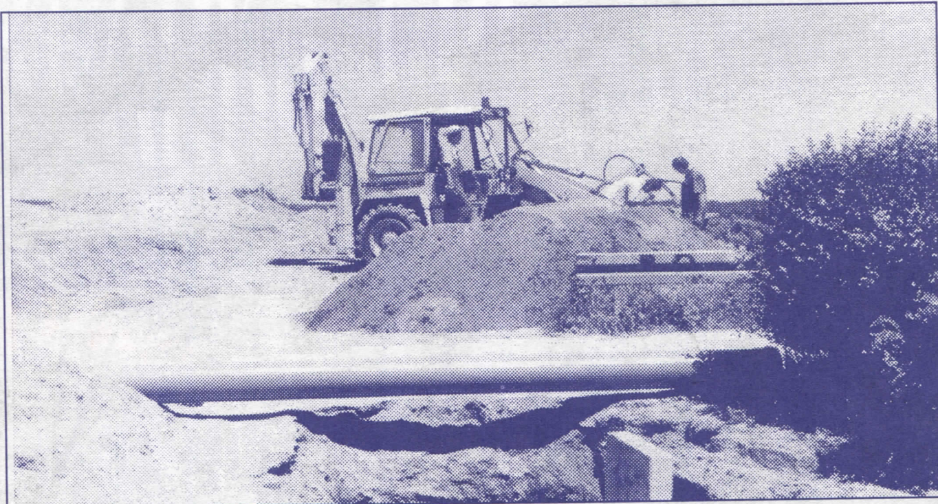
Изградња водоводне мреже и прикључење на београдски водовод
