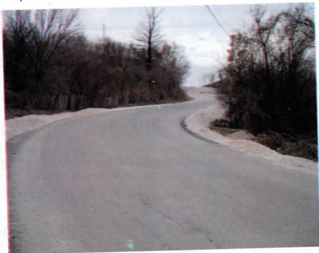
Комунална реконструкција дела регионалног пута ка Катуну
